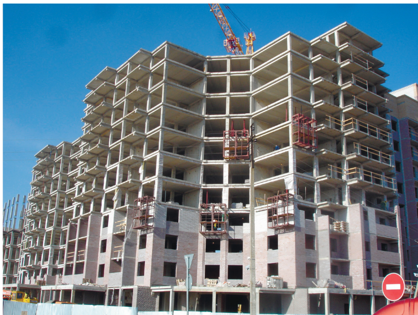
Массовая застройка 9–12-этажными жилыми домами со встроенным 1 этажом с применением сборно-монокристаллического каркаса с пустотным настилом /2014 г., Великий Новгород/
