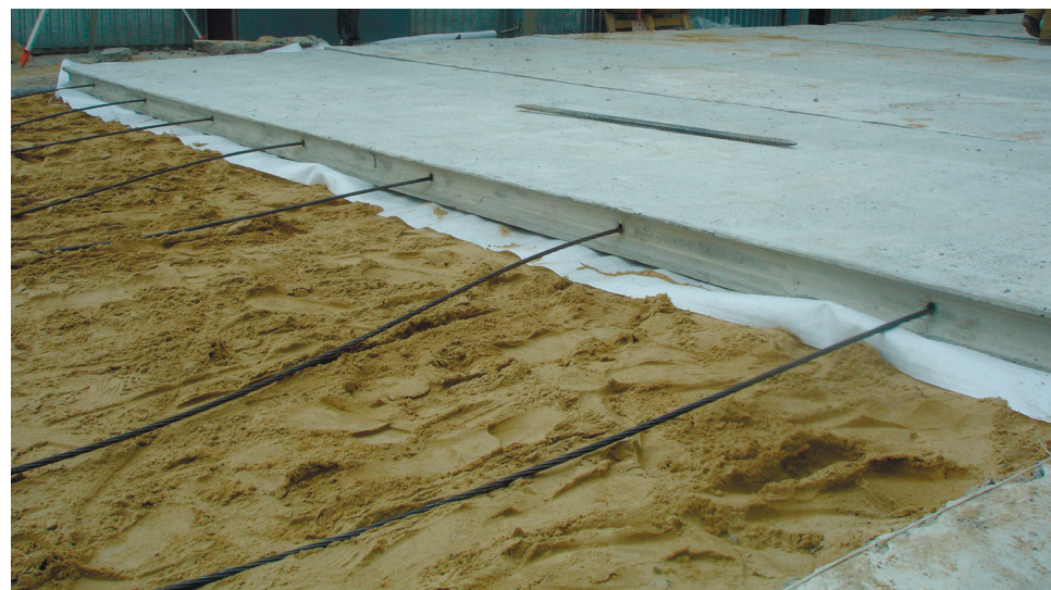
Строительство участка дороги с применением преднапряженных пазогребневых дорожных плит / ЗАО «Рекон», г. Чебоксары, сентябрь 2014 г. /
