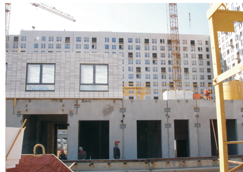
Массовая застройка жилыми домами КД и преднапряженными плитами перекрытий изготовленными на универсальных стендах /ЗАО «Рекон», ООО «НСС» г. Обнинск и ГК «ПИК» г. Москва. 2018 г./
